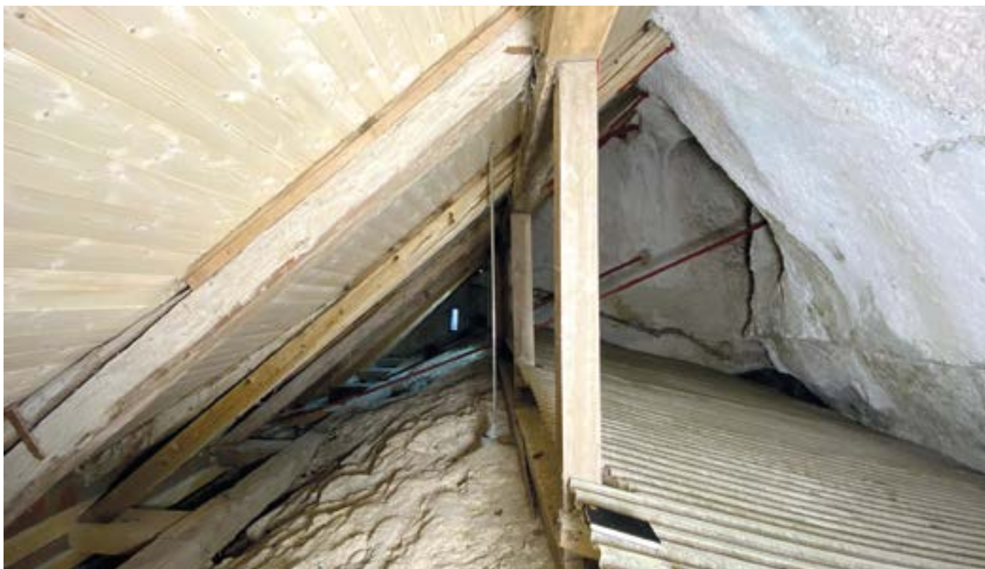
Das neue Unterdach der St. Verenakapelle.
