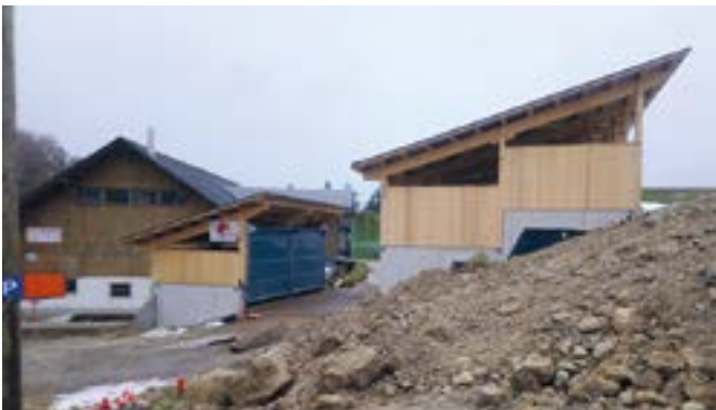
Die beiden Holzschnitzellager der neuen Holzschnitzelheizung.
